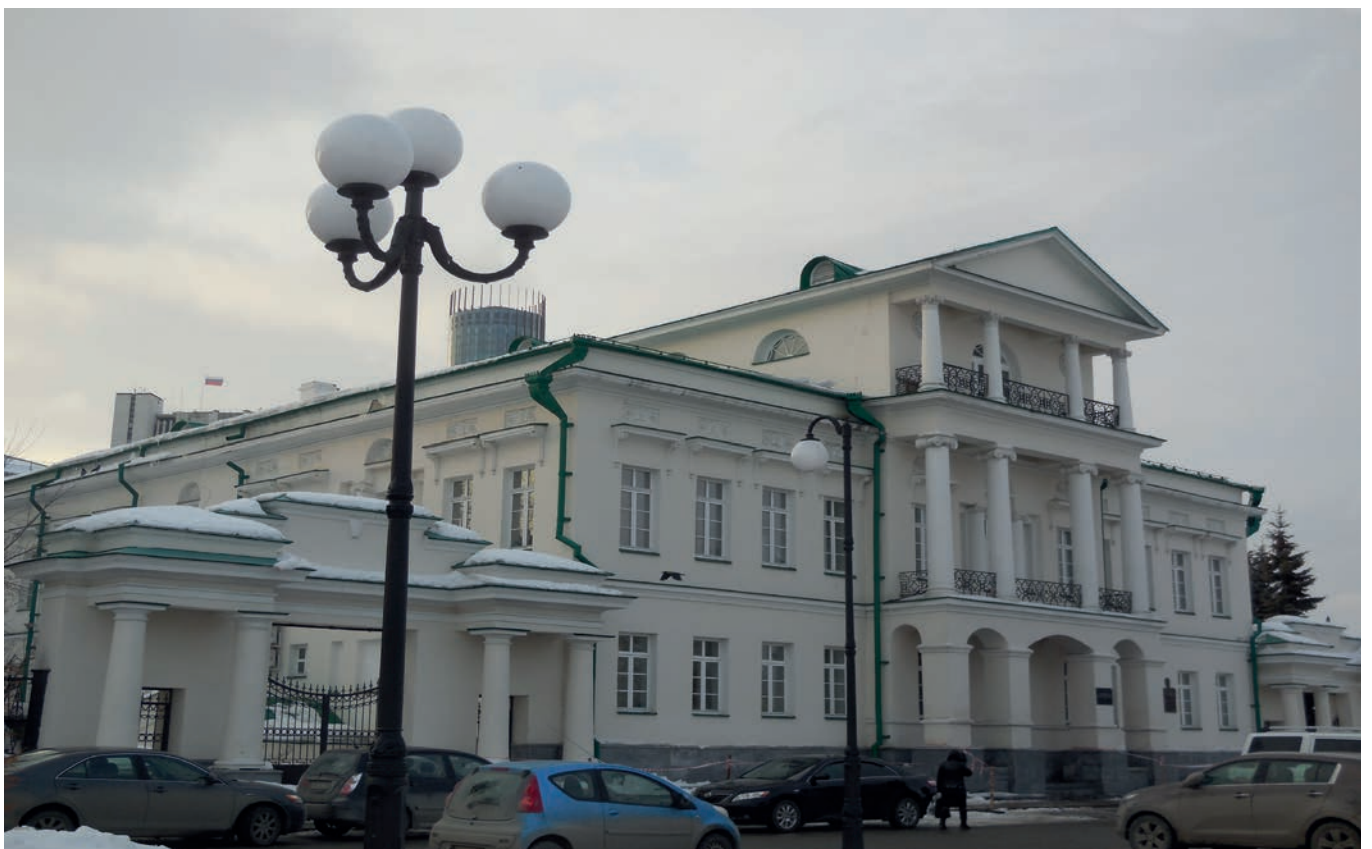
Нынешний вид здания. Областная больница № 2. Фото автора
