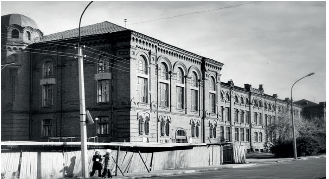
Строительство перехода из 2-го в 4-е здание СГИ (1980 год)
