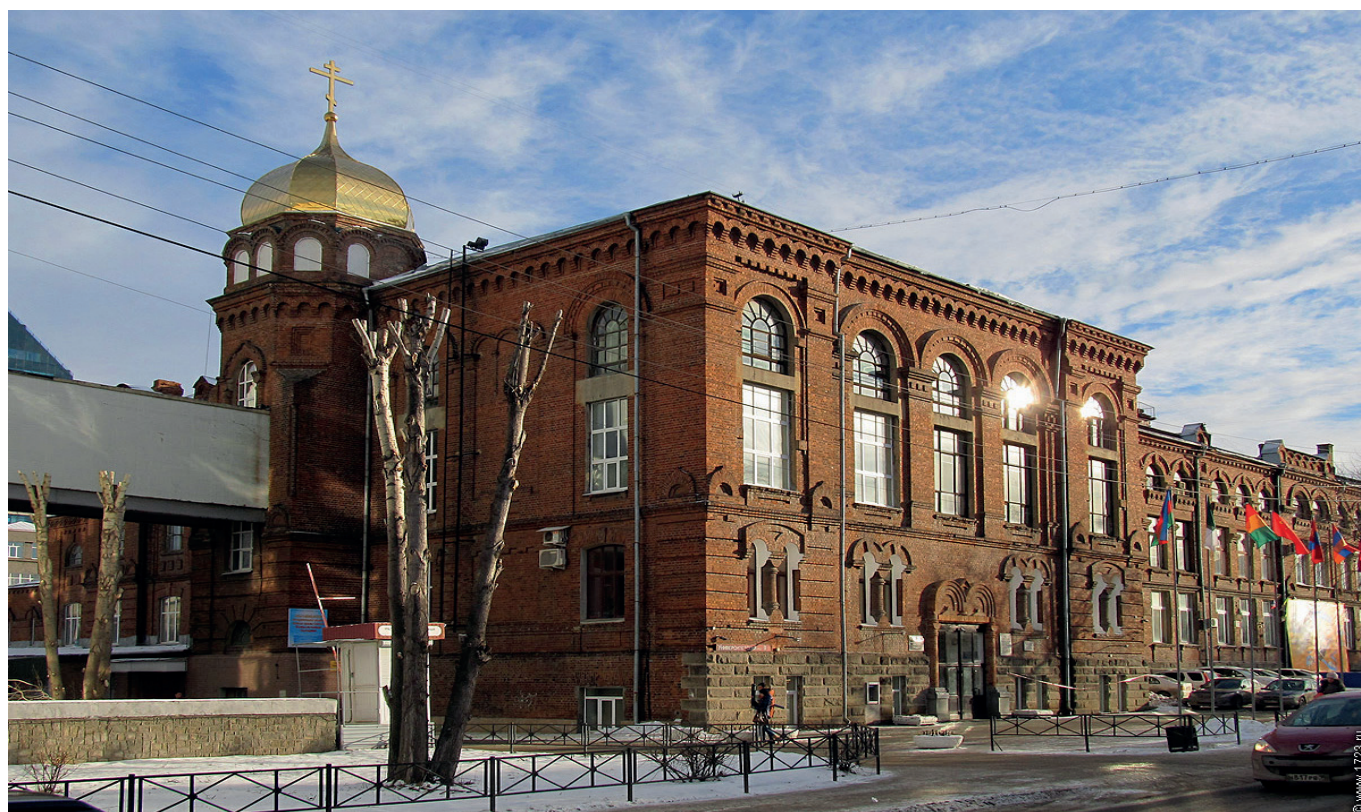
Вид учебного корпуса после монтажа купола церкви (2014 год)
