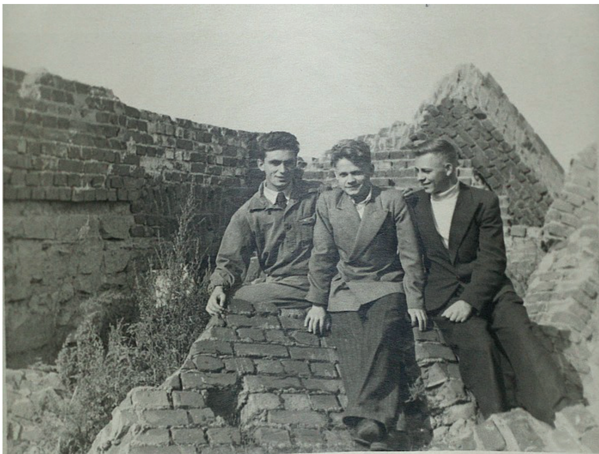
... И то, что от него осталось (руины недостроенного здания УГИ)
