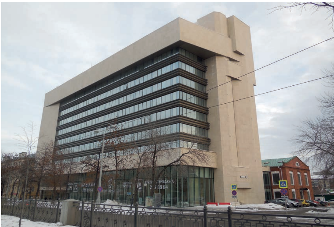
На месте дома Барабошкина, который был снесен, построено большое здание завода ОЦМ, однако кирпичное здание аффинажного завода сохранилось (см. на фото справа). Фото автора
