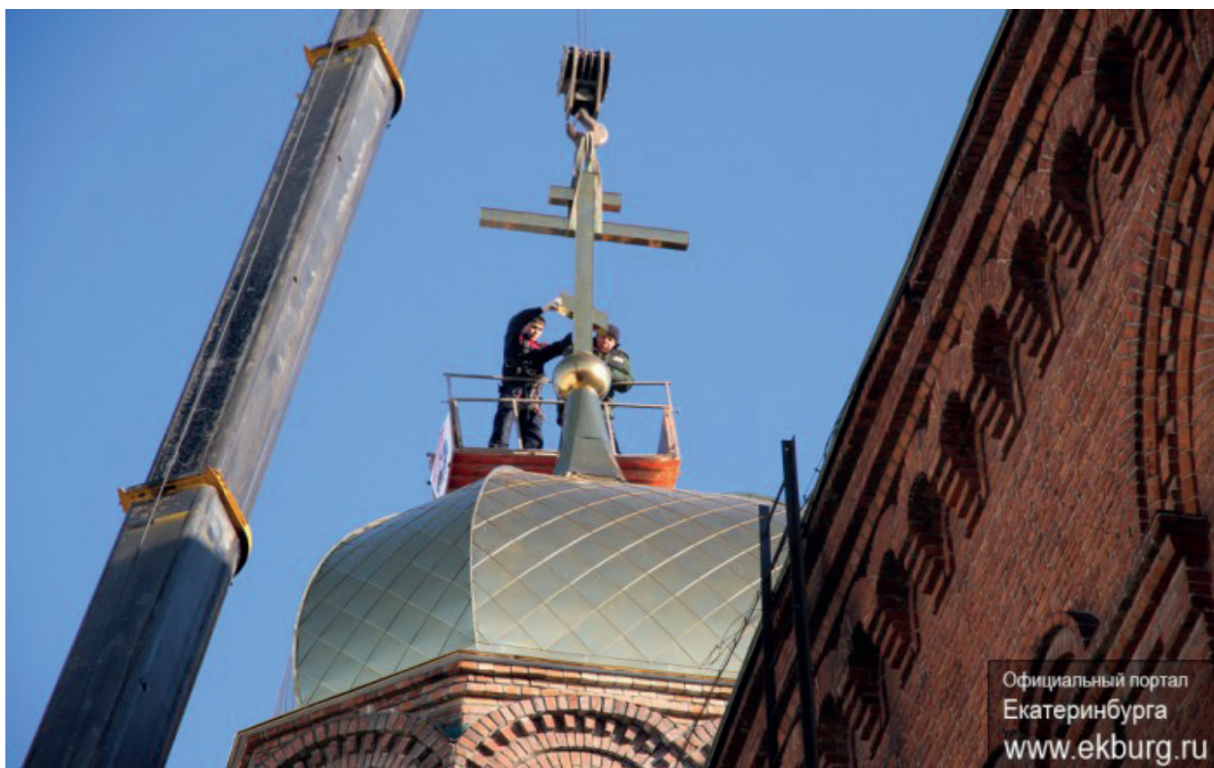
Монтаж купола церкви Екатерины Великомученицы (2014 год)
