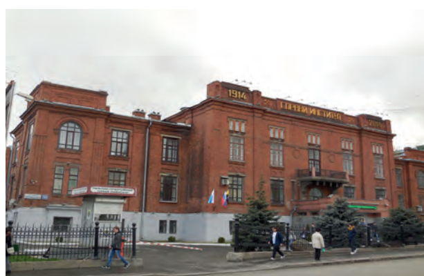
Современный вид здания. Фото автора.
