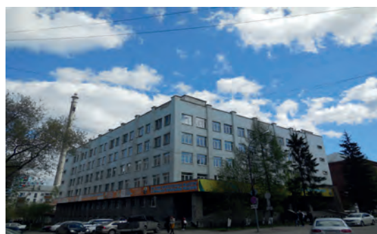
Современный вид 4-го корпуса УГГУ. Фото автора.
