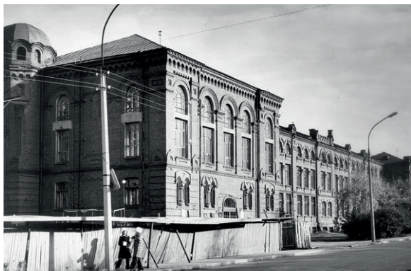
Строительство перехода из 2-го в 4-е здание СГИ (1980 год)
