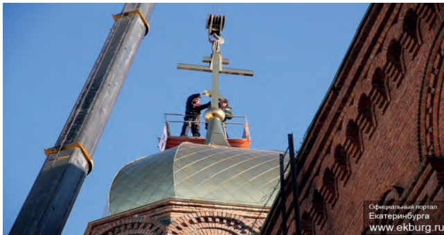
Монтаж купола церкви Екатерины Великомученицы (2014 год)
